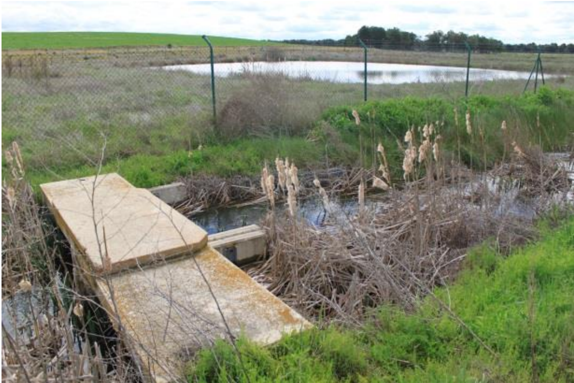
Figura 7. Efluentes de una depuradora por lagunaje mezclado con aguas fluviales en un canal de recarga gestionada para alcanzar el estándar de calidad exigido.
