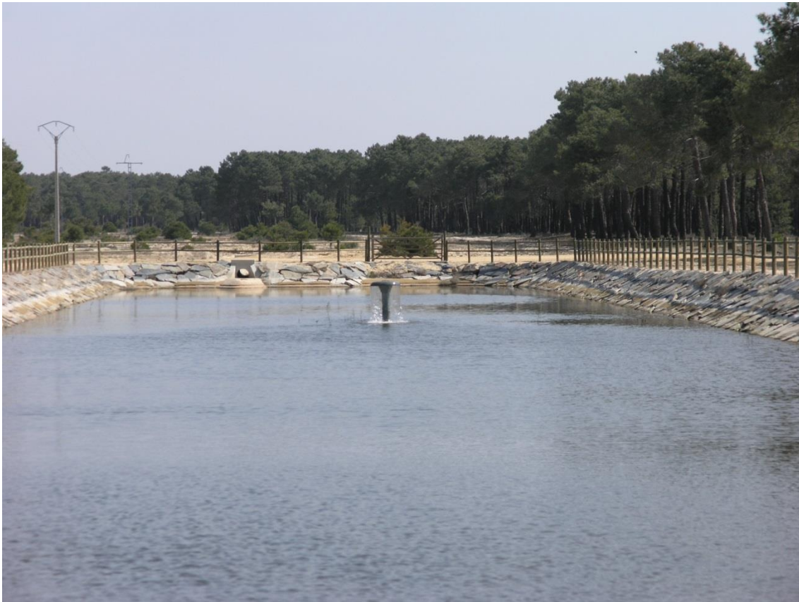
Figura 8. Balsa de decantación/infiltración en el acuífero de Los Arenales.
